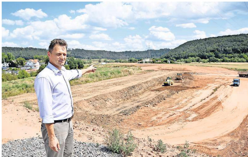
Bernd Marquardt, Fachbereichsleiter Bau bei Hessen Mobil, zeigt die Bauarbeiten bei Sarnau für die Umgehungsstraße B 252.
