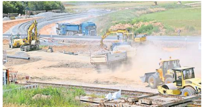
Die Bauarbeiten bei Sarnau für die Umgehungsstraße B 252 schreiten voran.
