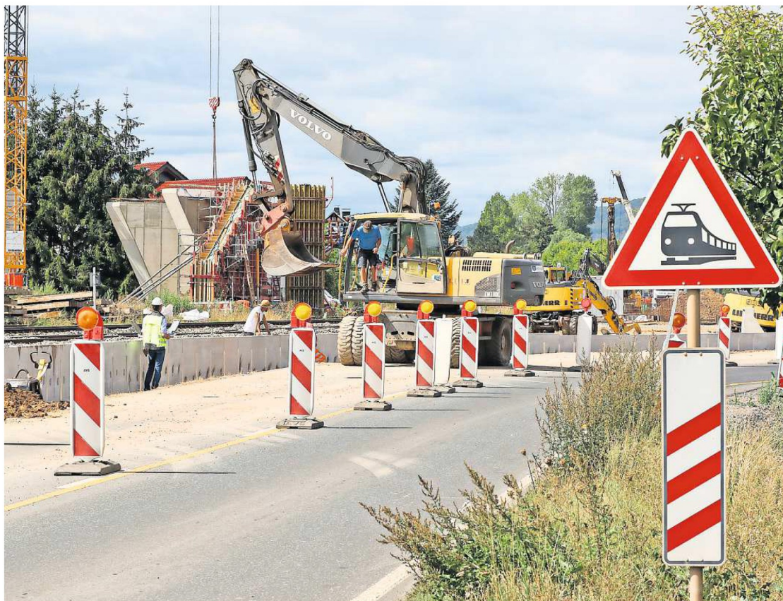
Das Foto zeigt die B-62-Baustelle in Höhe des Sarnauer Bahnhofs.
