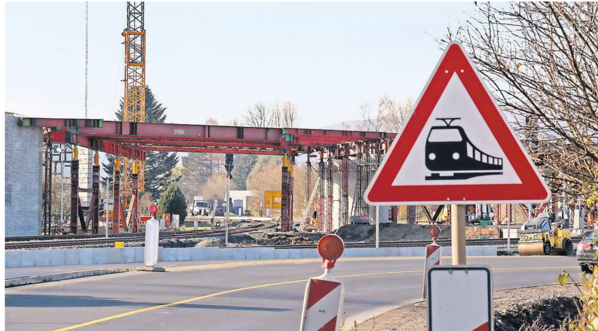
Das Brückenbauwerk zwischen Göttingen und Sarnau nimmt Gestalt an.
