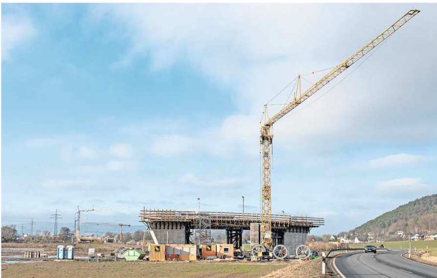
Die Brücken zwischen Göttingen und Cölbe nehmen immer mehr Form an.
