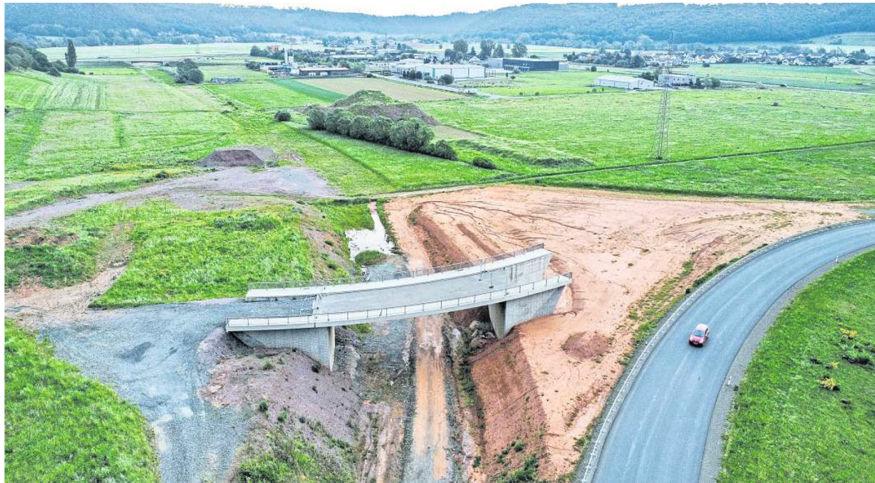
Blick auf den unfertigen Teil der Ortsumfahrung Münchhausen, Wetter und Lahntal in der Nähe von Sterzhäusen.
