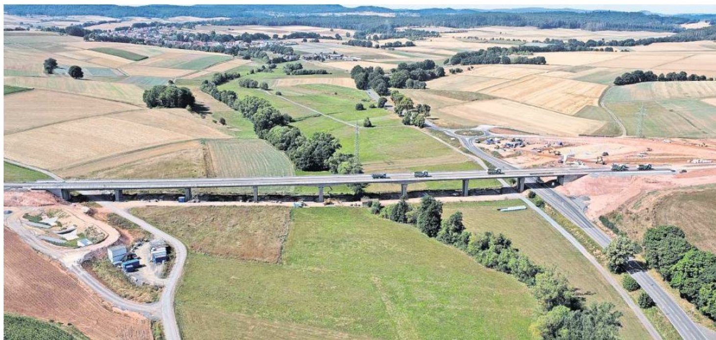
Die Wollmartialbrücke bei Münchhausen ist fertig.
