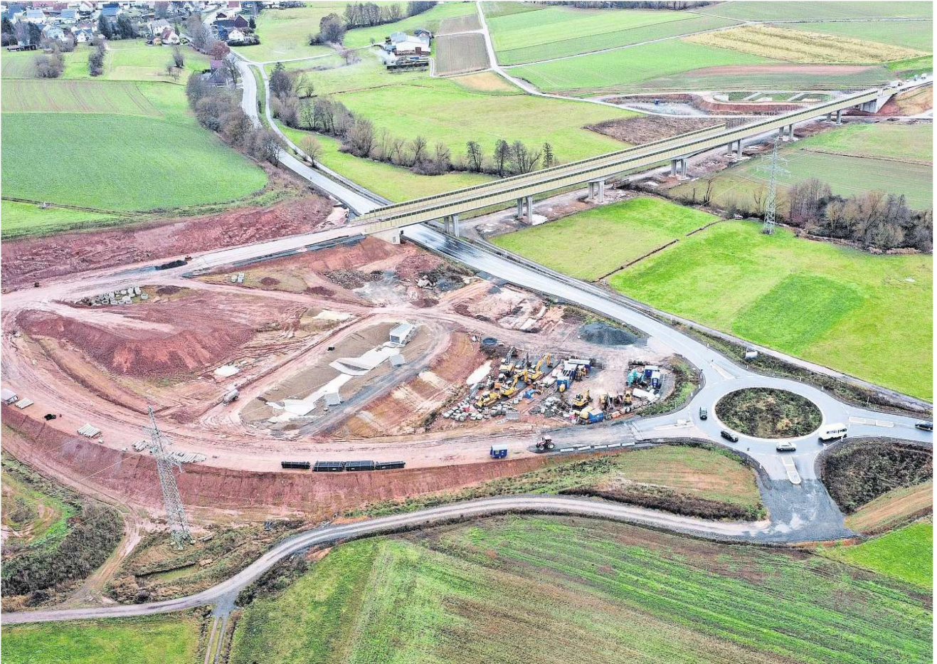
Die B-252-Ortsumgebung MüWeLa ist am Werden. Die Luftaufnahme zeigt die Wollmartalbrücke die über die B 236 führt und den neuen Anschluss-Kreisel. FOTO: NADINE WEIGEL
