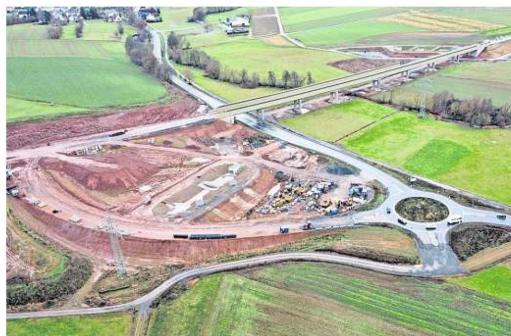
Die Baustelle der B252-Ortsumgehung bei Münchhausen.
